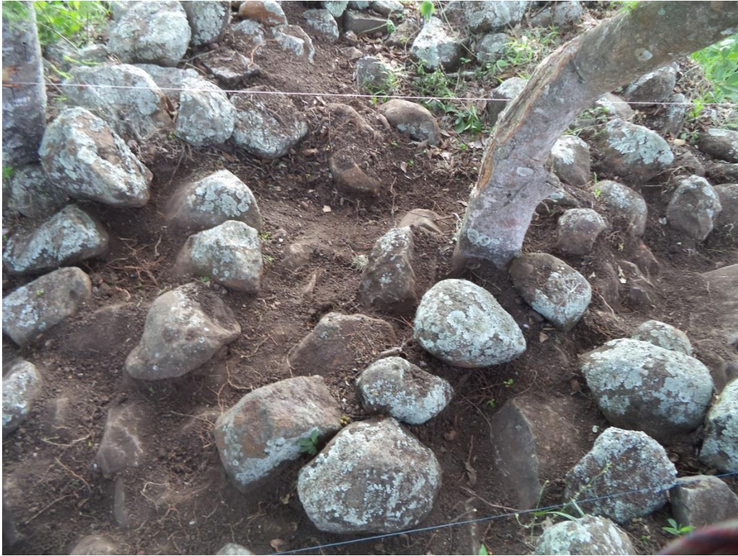
Figura 124 Estructura D3-5 Basamentos y Saqueo. Foto: E. Alvarez
