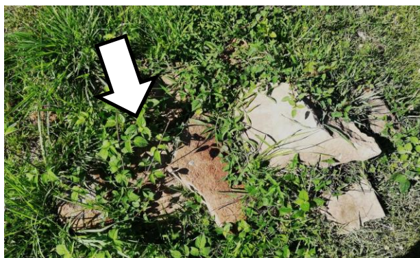
Figura 152 Piedras lajas sobre edificio C4-2, Fotografía Ch. Martínez.
