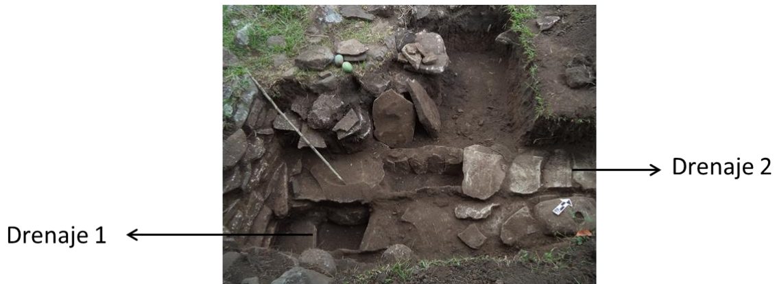
Figura 140 Pozo 5 Drenaje 1 y 2
