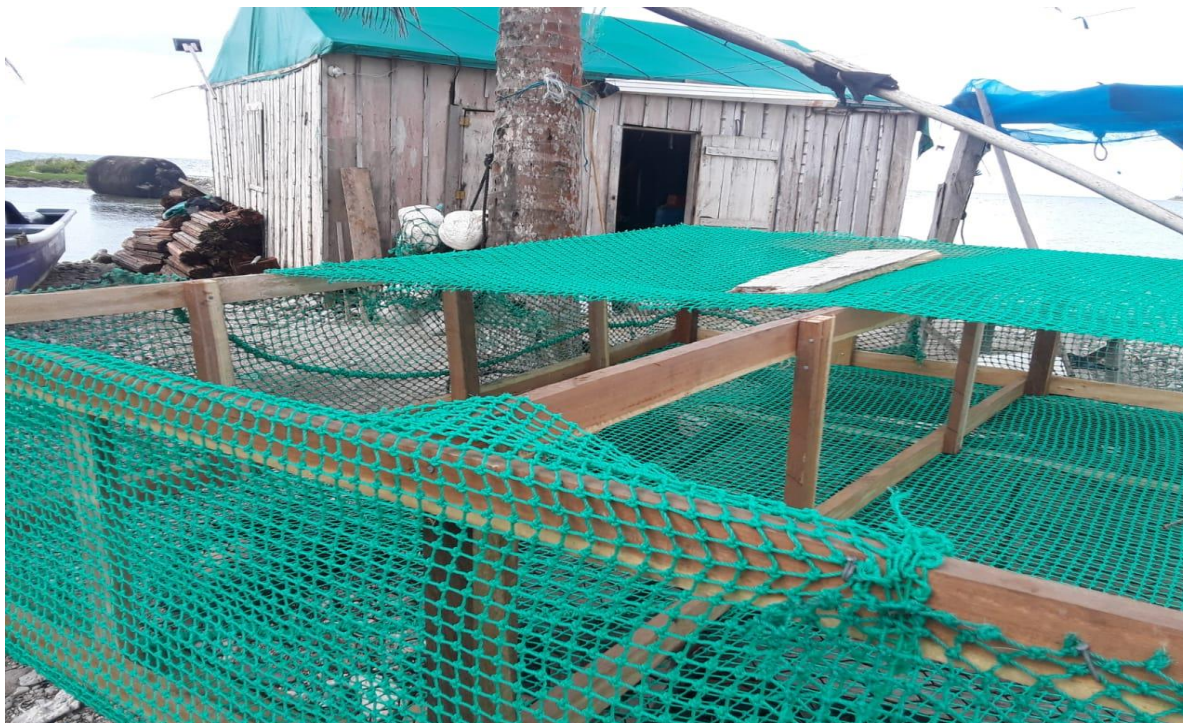
Jaula flotante en proceso de construcción. (Fotografía tomada por Ing. Lindolfo Hodgson)
